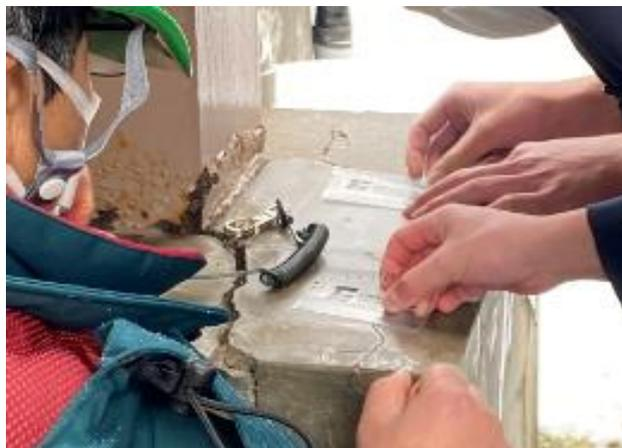
コンクリート調査(ひび割れ幅の計測)
