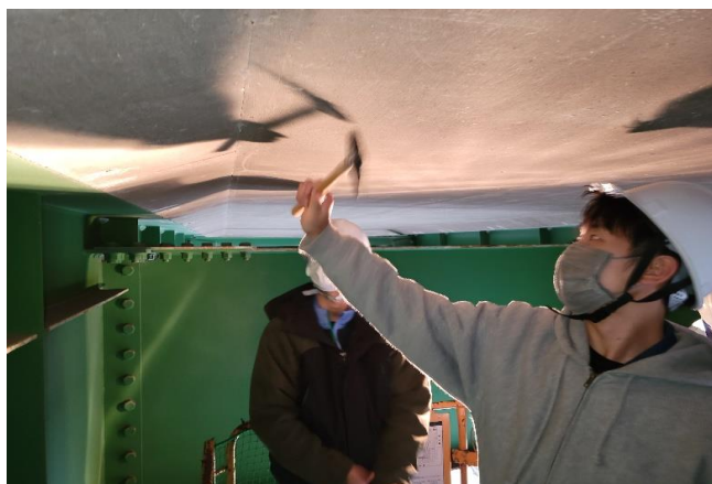
高所作業車によるコンクリート調査 (コンクリート床板の打音調査)
