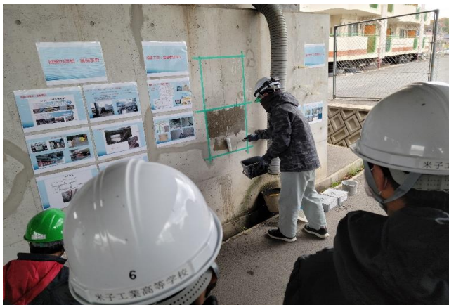
コンクリート補修工事の見学 (含浸剤塗布)
