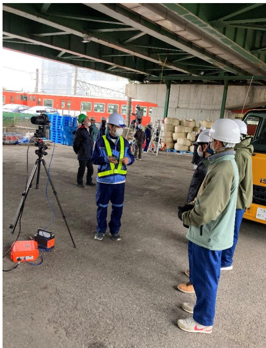
コンクリート調査 (高感度写真撮影によるひび割れ調査)
