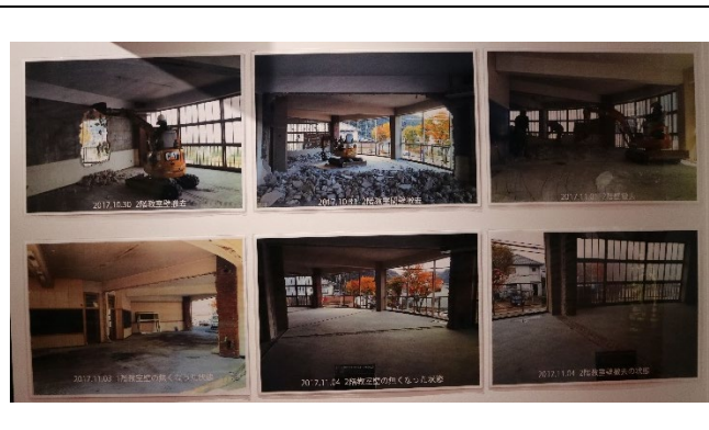
耐震補強工事の様子[出典：館内展示写真]
