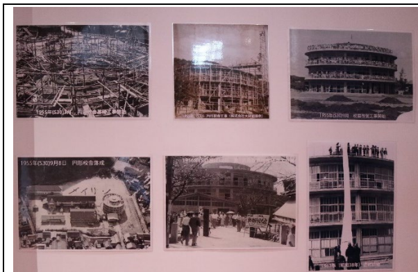
工事の様子 [出典：館内展示写真]
