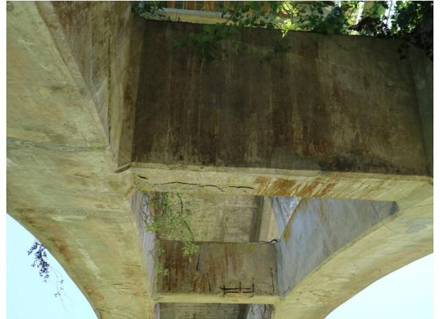
アーチ部 鋼材腐食に伴うひび割れが確認できる。
